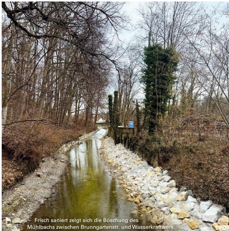
Frisch saniert zeigt sich die Böschung des Mühlbachs zwischen Brunngartenstr. und Wasserkraftwerk.
