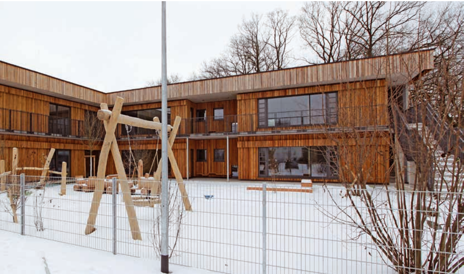
Mit Holz gebaut: Die Fassade der neuen Krippe ist aus Holz, ebenso die Spielgeräte im Garten.
