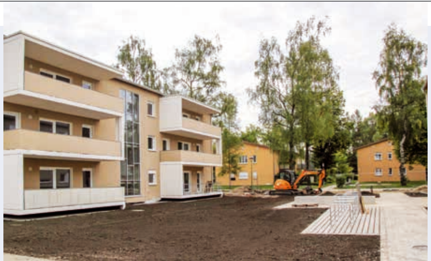
Noch sind nicht alle Außenarbeiten erledigt, aber es zeichnet sich schon ab: Am Rennplatz wohnt man im Grünen.
